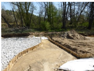
21.04.2021 Bau eines Fangedamms im Altarm
