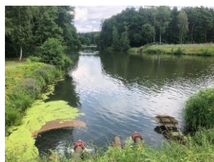
06.08.2021 Ablauf Dränagegraben West in Spree
