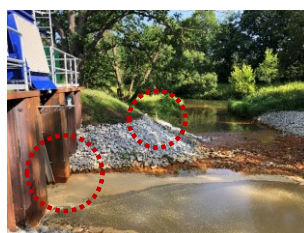
13.07.2021 Zulauf und Ablauf MWBA
