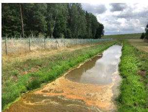
09.07.2021 Dränagegraben Ost vor Spree
